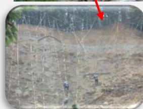
▲法面整形が終わったところに落石を防ぐ防護網を張っています R1 10/7現在
