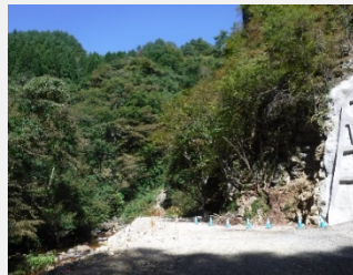
▲不動沢第4砂防堰堤建設予定地（準備中）
