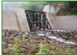
塩の川第6砂防堰堤
