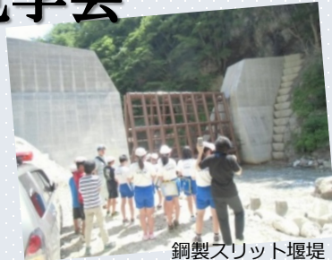
鋼製スリット堰堤
