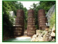
荒川第13砂防堰堤 (セル式コンクリートスリット)
