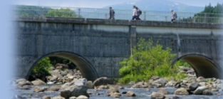
堰堤と川底に段差がない工法で魚や人が行き来することができる自然に優しい砂防施設です。
