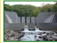
須川第2砂防堰堤 (コンクリートスリット)
