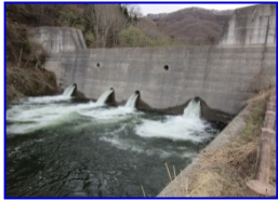
天戸川第1砂防堰堤
