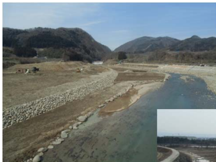
今年度工事を行っている奥松川橋から上流の様子。
