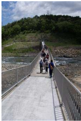
荒川遊砂地大暗渠砂防堰堤は橋のよう？
