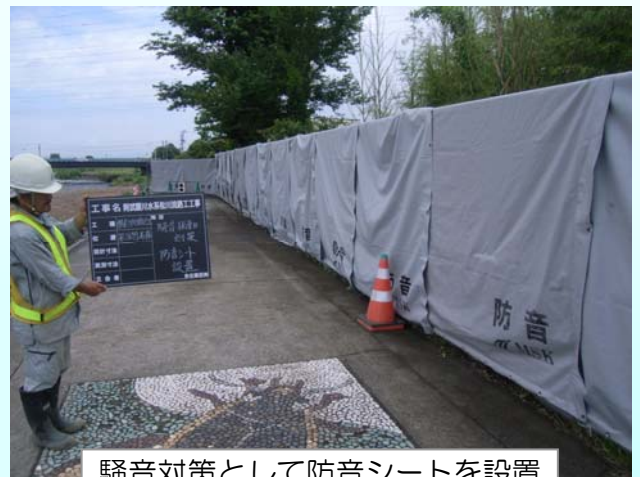
騒音対策として防音シートを設置しました。
