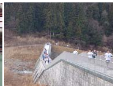
大暗渠砂防堰堤を駆け抜ける
