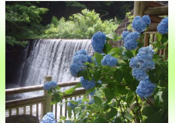
土湯温泉町の紫陽花と東鴉川第一堰堤
