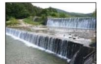
①地蔵原えん堤
