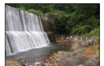
③荒川第5砂防えん堤
