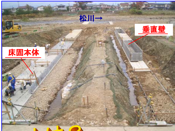
右岸側堤防より撮影
