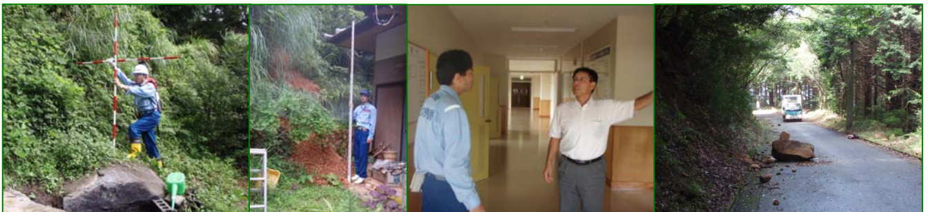
急傾斜地の点検状況
