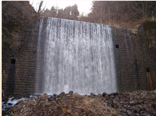
東鴉川第3砂防堰堤
