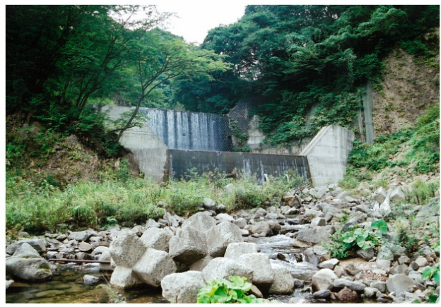
塩の川第1砂防堰堤
