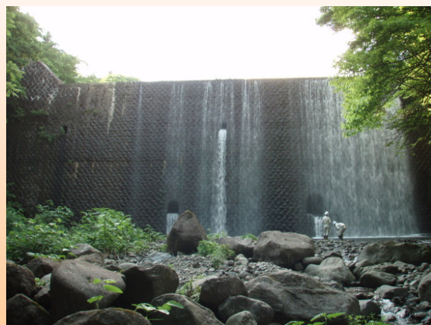
塩の川第4砂防堰堤
