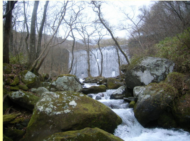
東鴉川第4砂防堰堤
