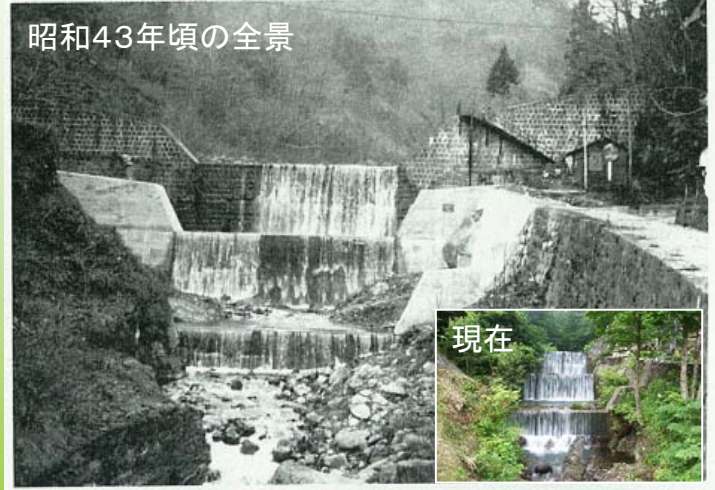
東鴉川第1砂防堰堤
