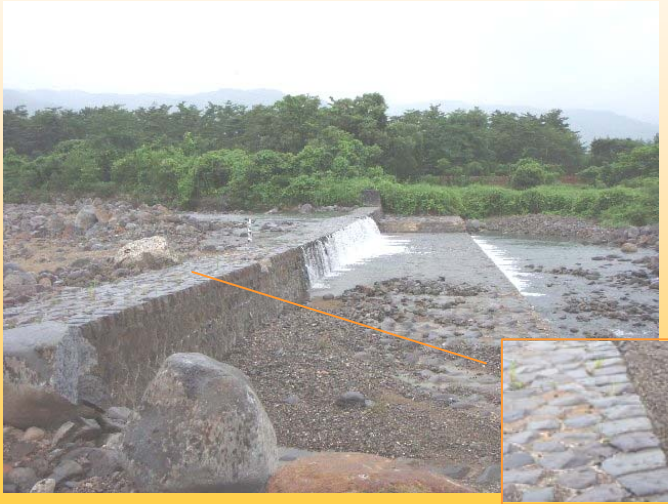
荒川第4床固工
