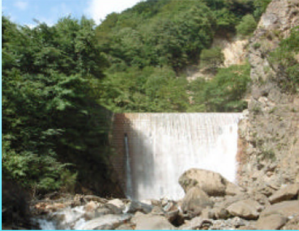
荒川第3砂防堰堤
