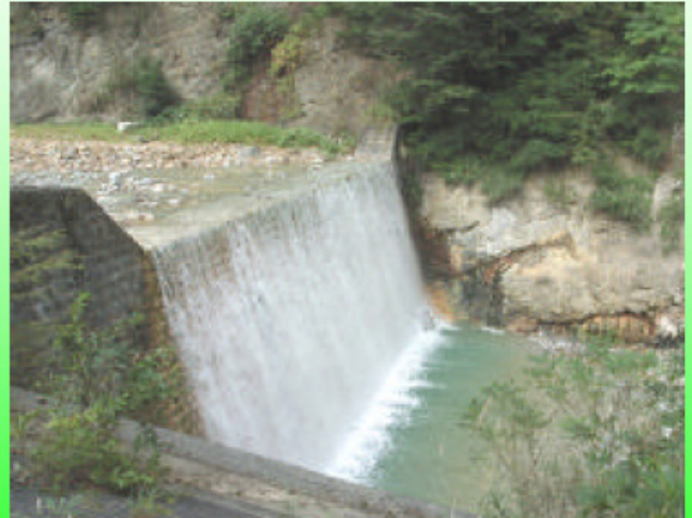
荒川第8砂防堰堤
