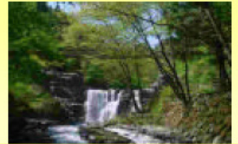
東鴉川第2砂防堰堤
