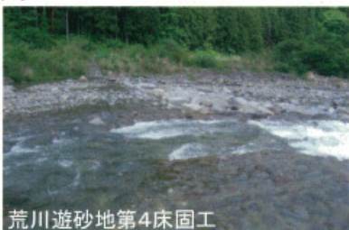
荒川遊砂地第4床固工
