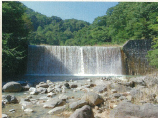
荒川第7砂防堰堤
