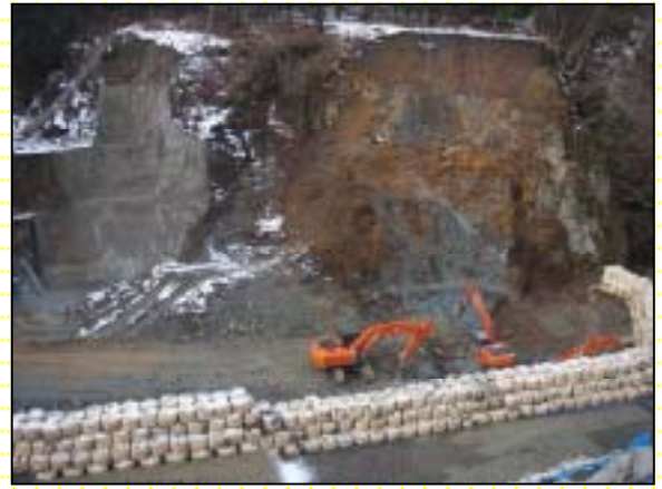
掘削作業を行っています。
