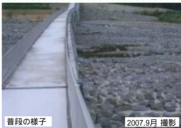
国道115号から望む大暗渠（平成18年3月竣工） 大暗渠は、堤長252m、堤高9mの砂防えん堤です。
