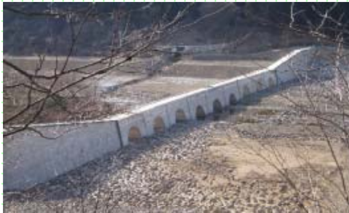
国道115号から望む大暗渠（平成18年3月竣工） 大暗渠は、堤長252m、堤高9mの砂防えん堤です。
