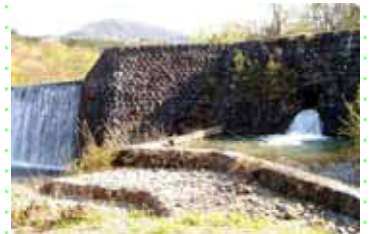
堰堤本体と取水口
