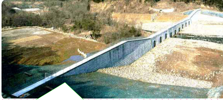
荒川遊砂地大暗渠砂防えん堤に防護柵を設置。
