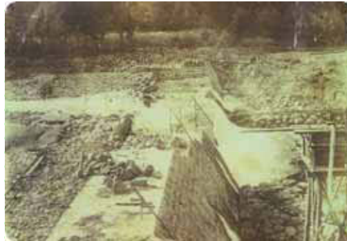
建設当時の工事風景 (大正～昭和初期)
