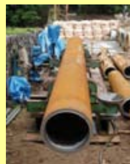
堤体に立ち込まれる鋼管杭
