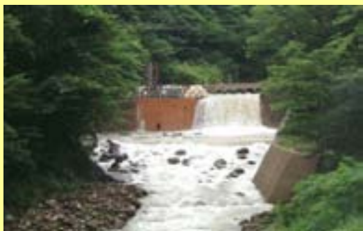
川上第1砂防堰堤(全景) 昭和21年完成。粗石コンクリート造り (自然石とコンクリートの混合)
