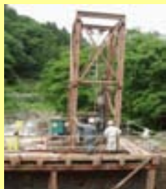
ボーリング作業用のやぐら
