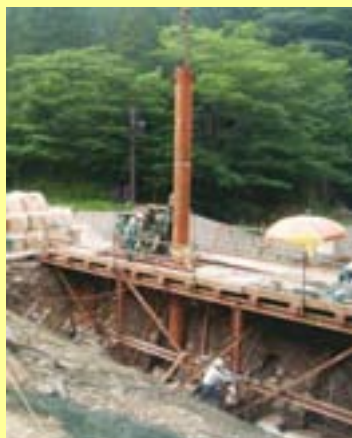
鋼管杭を立て込んでいる状況
