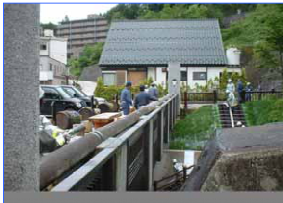
東鴉川に降りる非常用階段を利用してポンプで水を汲み上げます。
