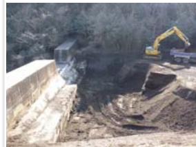
緊急ハード対策の例 2011年に噴火した霧島山(新燃岳)で行われた砂防堰堤の緊急除石
