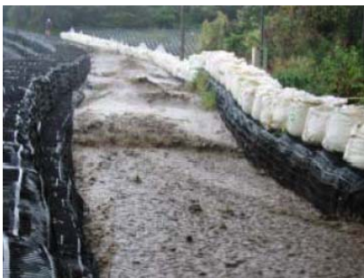
大型土嚢を配置した仮導流堤（三宅島）
