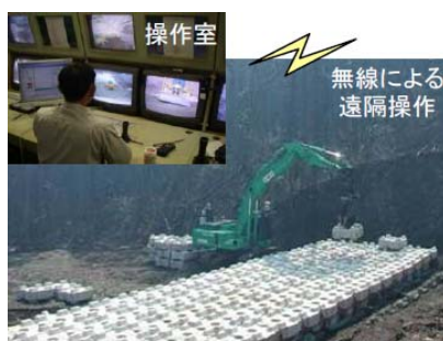
遠隔操作による堰堤施工（三宅島）
