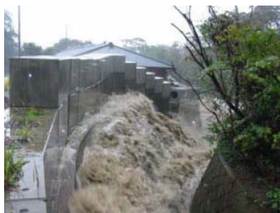
コンクリートブロックで嵩上げ（三宅島）
