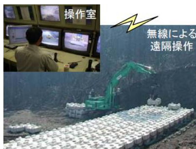
遠隔操作による堰堤施工（三宅島）
