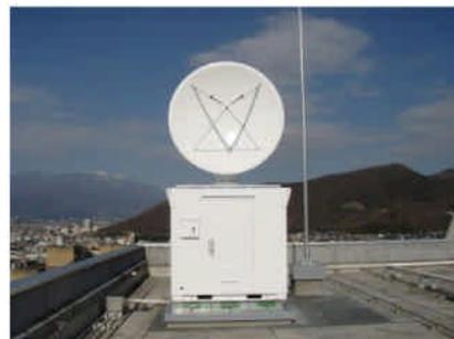
図 3-3 XバンドMPレーダ雨量計
