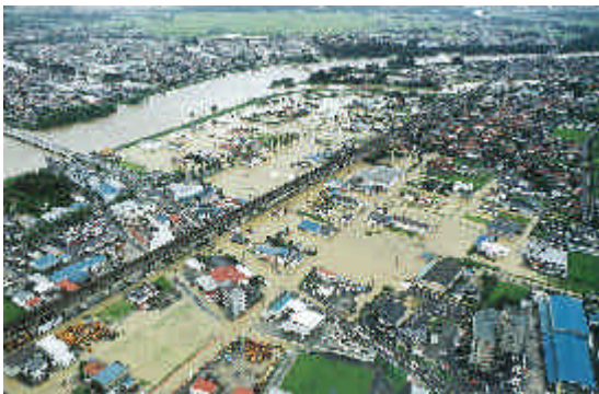
・金山橋付近(郡山市)
