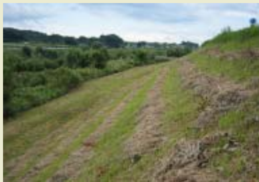
除草後の状態
