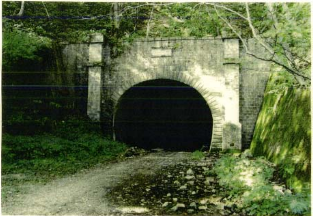
福島側③ニツ小屋隧道福島側
