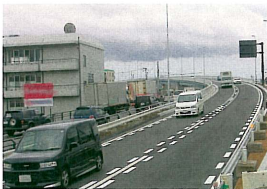
▲針生高架橋 (暫定2車線供用)
