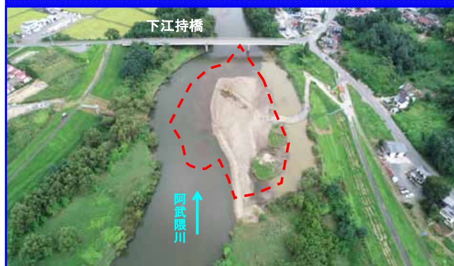
掘削中（令和元年9月撮影）
