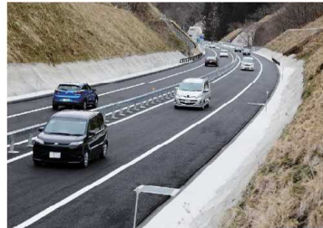
阿武隈東道路 供用後
