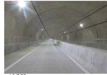
③ 塩山トンネル
