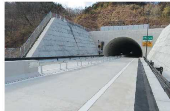
④ 馬館山トンネル
