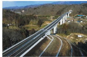
③ 月館高架橋
