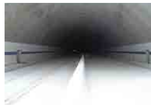
⑤ 松ヶ房トンネル舗装(完)
