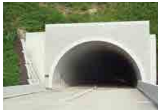
③ 楢這トンネル(完)
