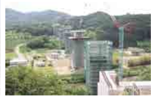
つきだて ④月館高架橋
