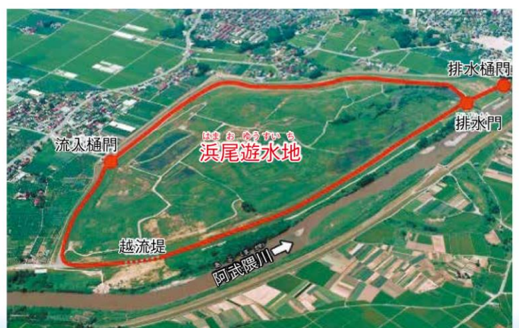
既存の遊水地例 (浜尾遊水地、須賀川市浜尾)
