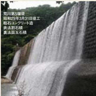
荒川第七堰堤 昭和25年4月1日竣工 粗石コンクリート造 表法割石積 裏法面玉石積
