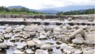
荒川第三床固工 練石積粗石コンクリート 昭和28年3月31日
