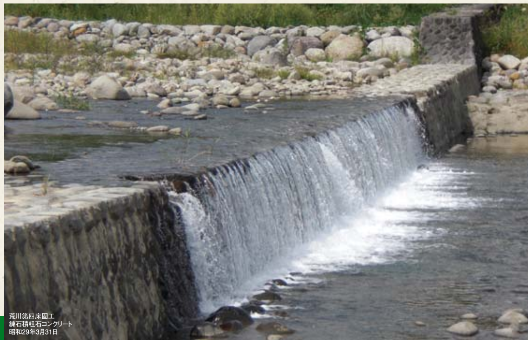
荒川第一床固工 練石積粗石コンクリート 昭和26年3月31日
