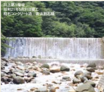
荒川第二堰堤 昭和13年6月30日竣工 粗石コンクリート造 表法割石積
