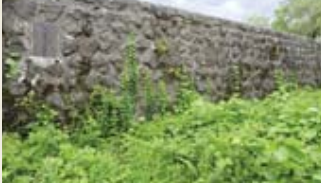
荒川第一床固工 練石積粗石コンクリート 昭和26年3月31日
