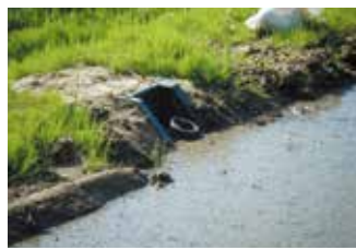
【須賀川市】田んぼダム(雨水を一時的に水田に貯留させる施設)の設置
