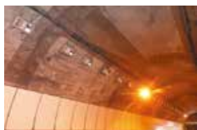
トンネル補修
