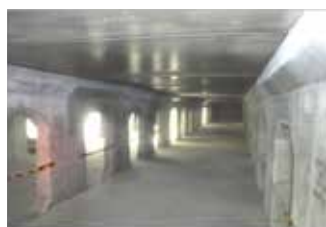
【郡山市】一時貯留施設の設置
