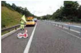
道路巡回の実施(1回/2日～2回/1日)
