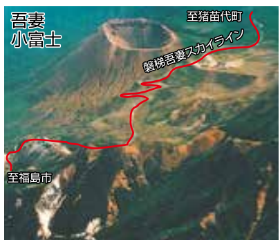
火山ガスで変質した脆弱な斜面
