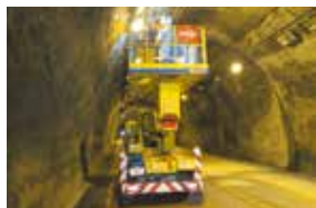
トンネル点検
