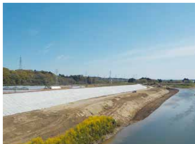
コンクリートブロック施工状況
