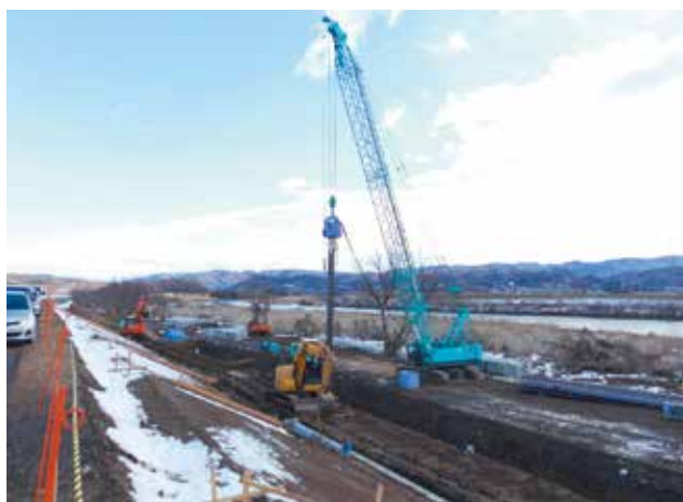
鋼矢板施工状況
