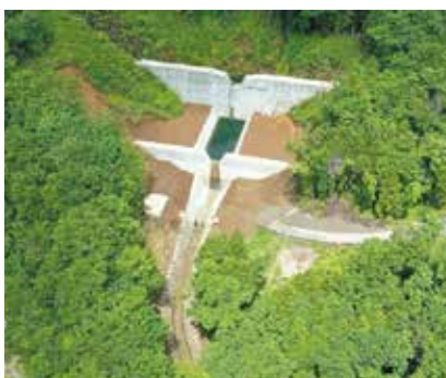
下高湯沢第1砂防堰堤(R4.3完成)
