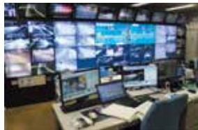
道路状況の24時間監視
