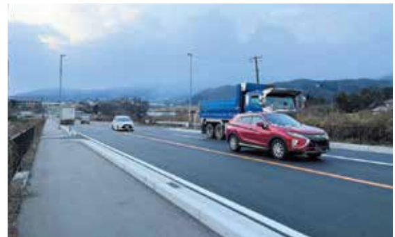
▲石母田工区開通後の状況
