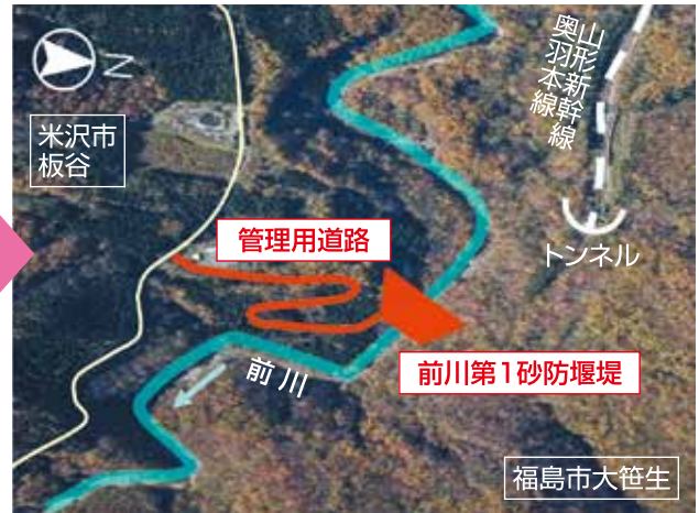
工事後【前川第1砂防堰堤】
