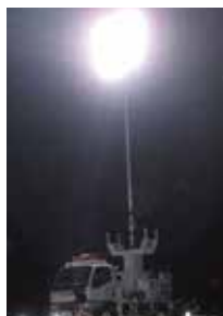
破堤箇所の応急復旧作業
