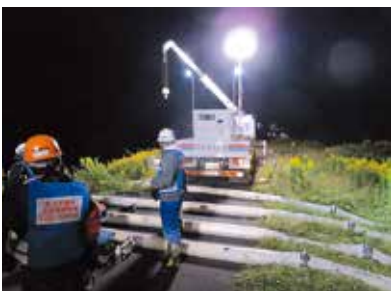
堤防越水箇所の排水作業
