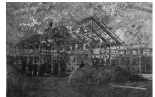
内務省当時の事務所新築状況(東北本線の捨場から石灰殻をトロ運搬によって埋立て、その上に荒川の瓦礫を表土として造成した。大正9年1月)
