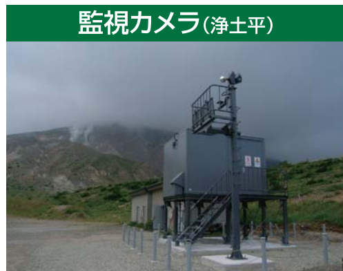
監視カメラ(浄土平) 火山噴火に起因する土石流等を監視します。
