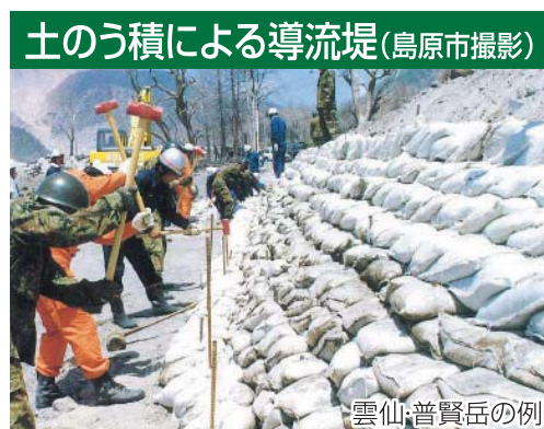
土のう積による導流堤(島原市撮影) 雲仙・普賢岳の例 溶岩流や火山泥流を安全な方向に導きます。
