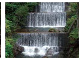
東鴉川第1堰堤(S26)
