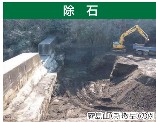
除石 霧島山(新燃岳)の例 砂防堰堤にたまっている土砂を取り除き、容量を確保します。
