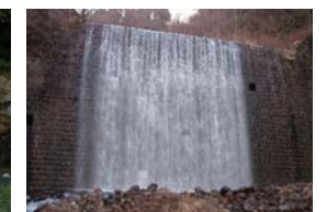
東鴉川第3堰堤(S28)
