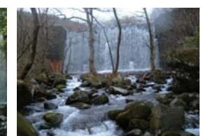
東鴉川第4堰堤(S32)
