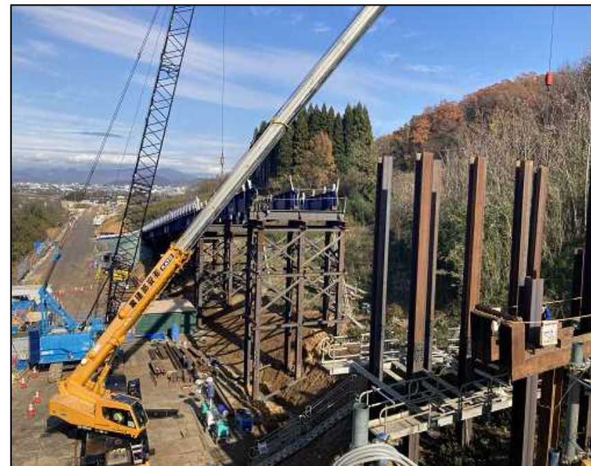
トンネル上部への作業通路設置中
