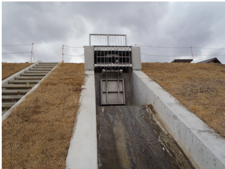
鳴瀬樋門(H25年度完成)
