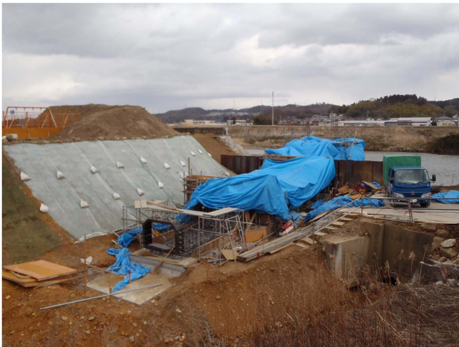
門柱本体及び函体の施工状況 (コンクリートの養生中)
