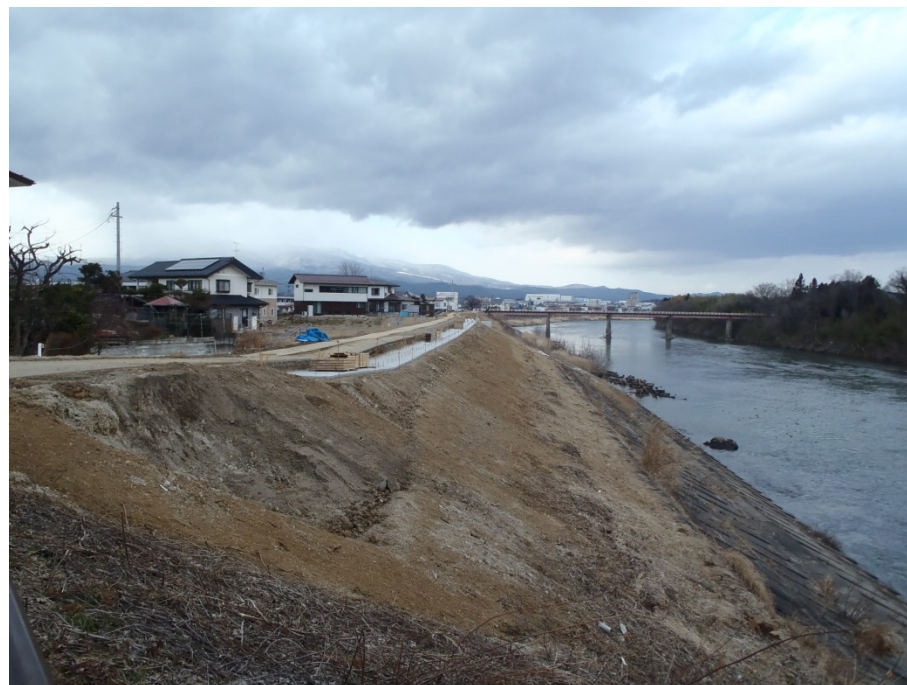
施工中の堤防
