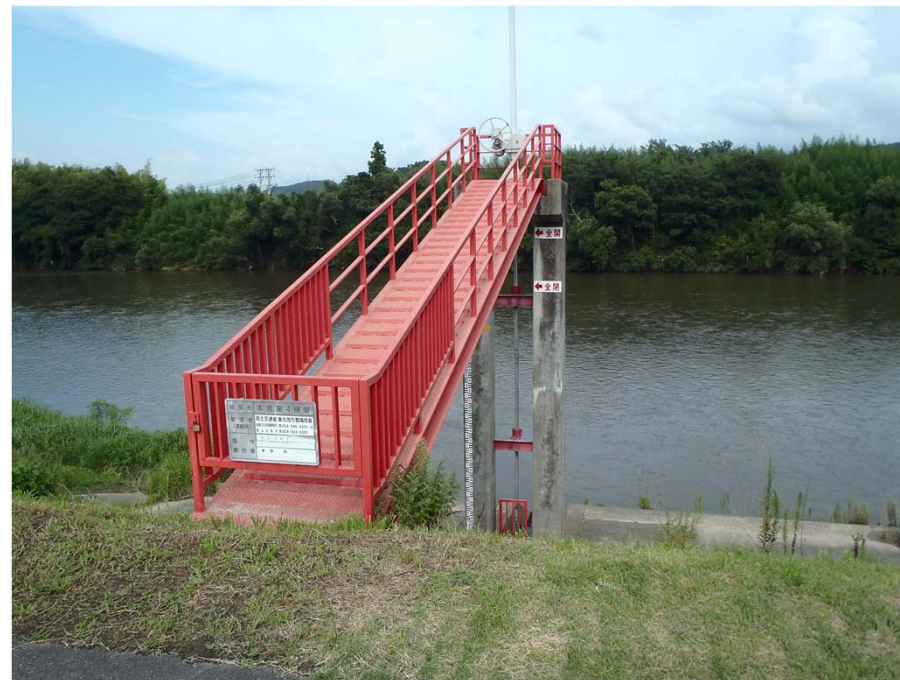
改築予定の第4樋門
