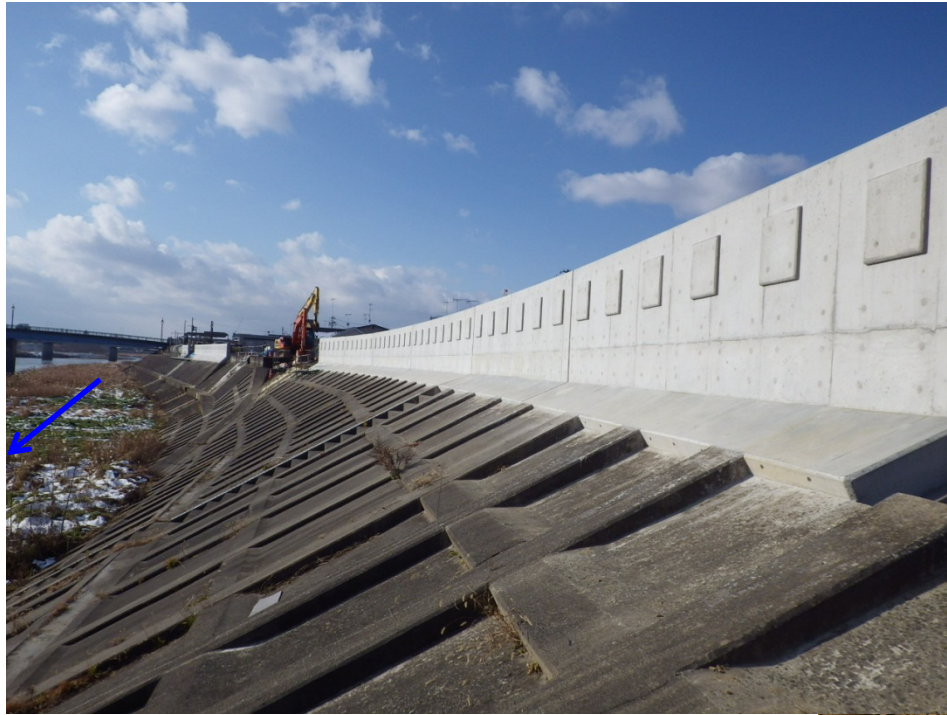
パラペットの修景（川側）
