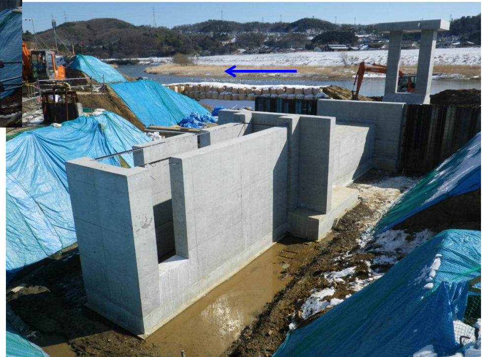
本宮第3樋門の工事状況（呑口：宅地側）
