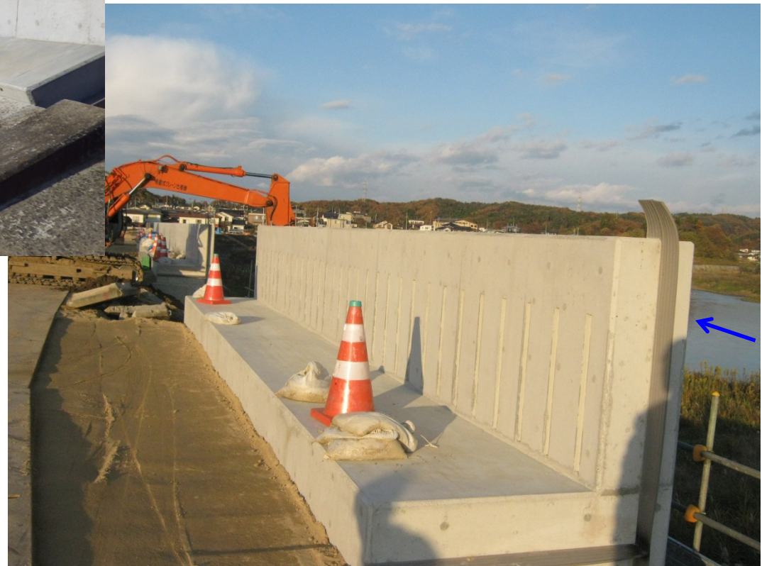
パラペットの修景（宅地側）
