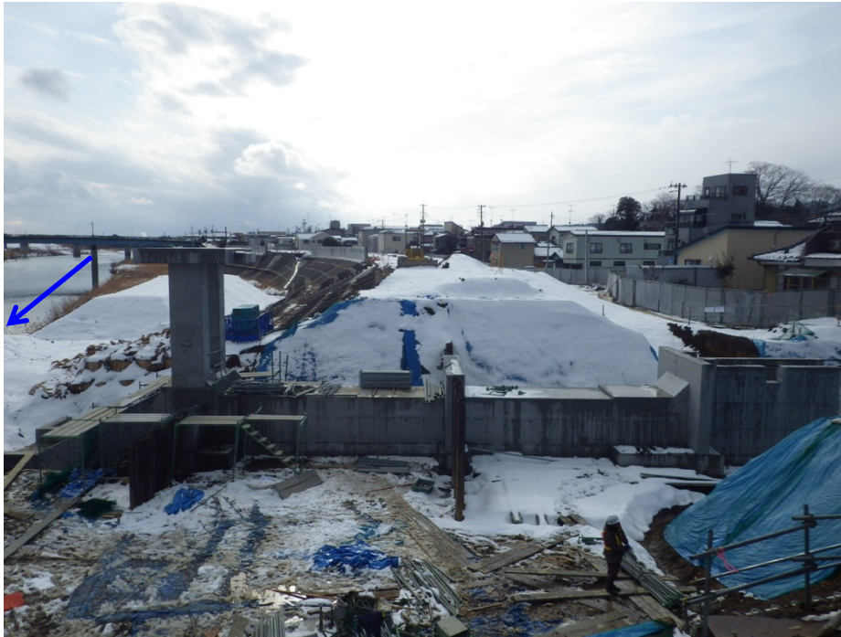
本宮第3樋門の工事状況（全体）
