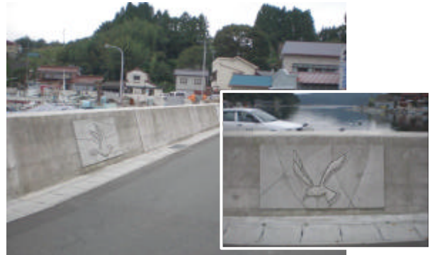
化粧型枠を使用した例
