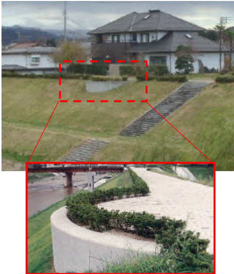
広瀬川 (旧梁川町) のバルコニーの事例
