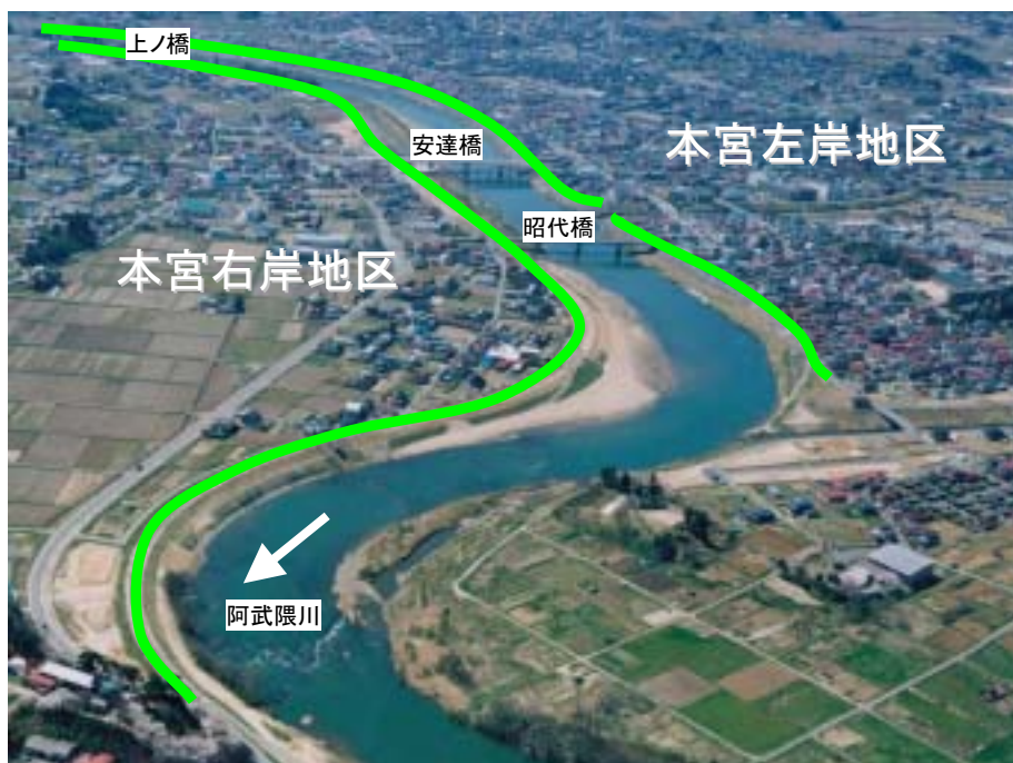
写真 1-4 本宮左岸・右岸地区(堤防整備予定箇所)
