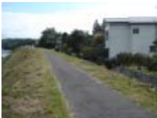
上ノ橋上流側の状況
