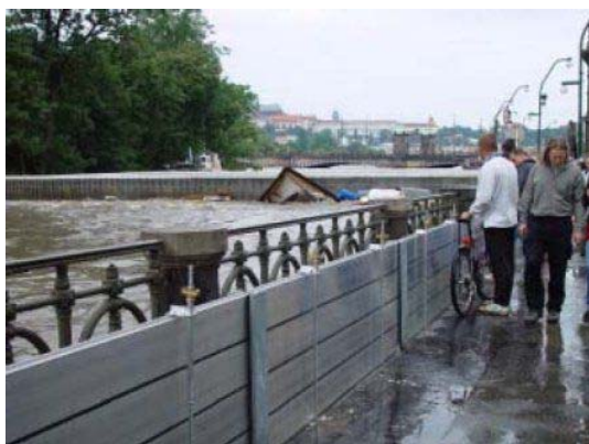
旧市街地に設置された可搬式のパラペット (エルベ国際保護委員会提供)
