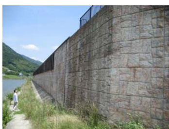
河川側から見たパラペット
