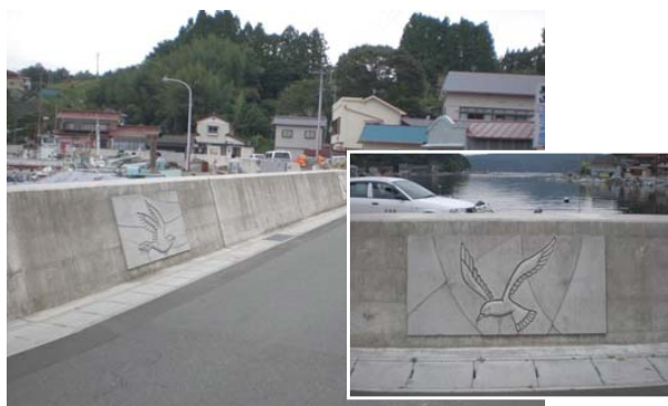
化粧型枠を使用した例
