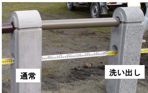
洗い出しコンクリート(支柱)の例
