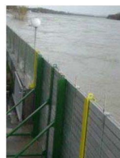
可搬式のパラペット、クレムス(ウィーン上流)の例 (パッサウ市提供)
