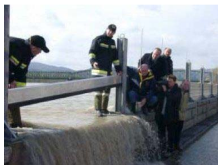
可搬式のパラペット、クレムス(ウィーン上流)の例 (パッサウ市提供)
