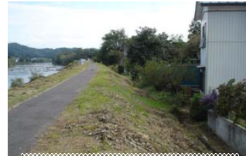
鳴瀬地区(上流側)の堤防
