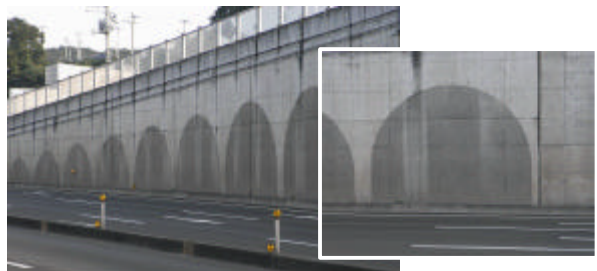
洗い出しによるコンクリート壁面の工夫例
