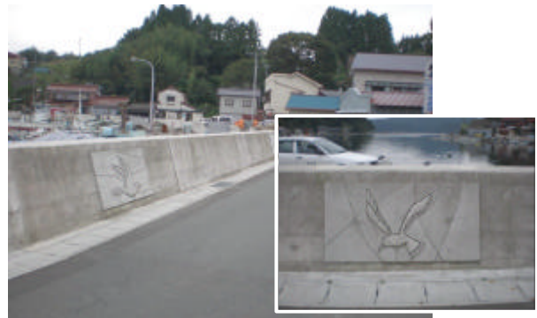
化粧型枠を使用した例
