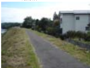
上ノ橋上流側の状況
