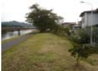
堤防沿いの桜・植栽
