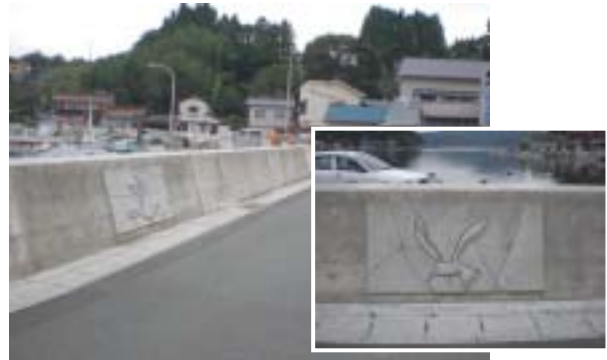
化粧型枠を使用した例
