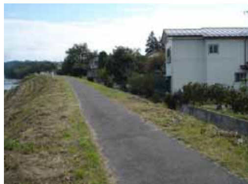
上ノ橋上流側の状況
