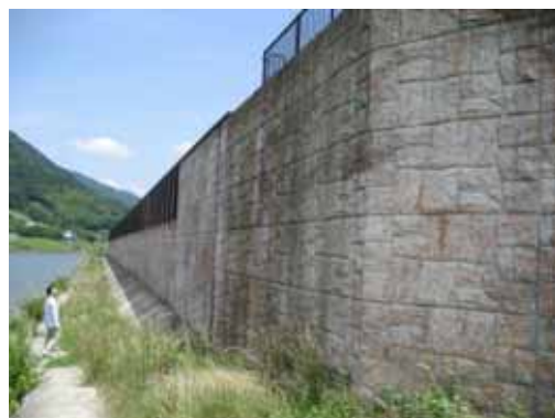
河川側から見たパラペット
