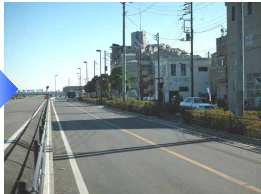
スーパー堤防の盛土と土地区画整理事業が完了
