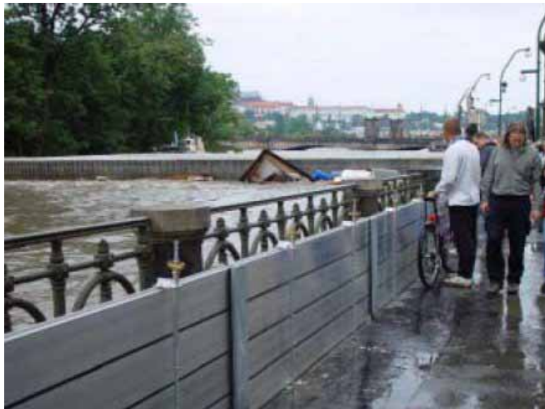
旧市街地に設置された可搬式のパラペット (エルベ国際保護委員会提供)
