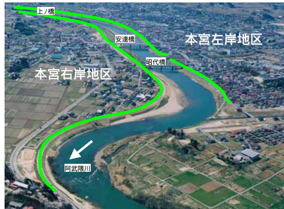
本宮左岸・右岸地区（堤防整備予定箇所）
