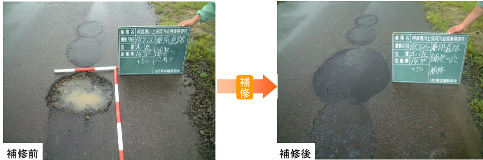
堤防天端舗装の補修
