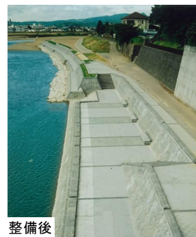
景観に配慮した護岸整備例（福島市御倉町） ～舟運の時代を偲んで復元された石積み護岸～
