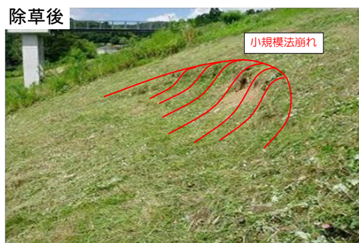
堤防除草により早期に発見された法崩れ
