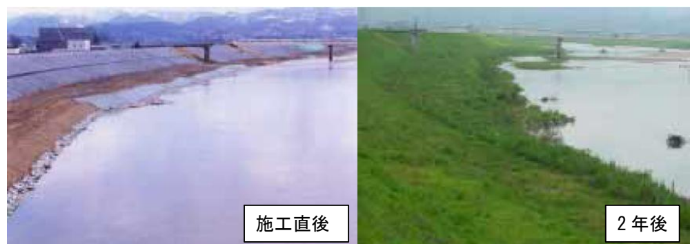
平成の大改修で行われた多自然川づくりの例(河口より60km付近)
