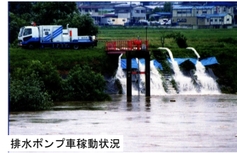
排水ポンプ車稼動状況
