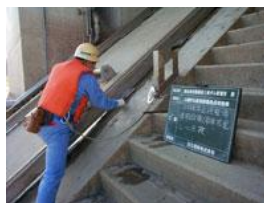
係船レールの点検状況
