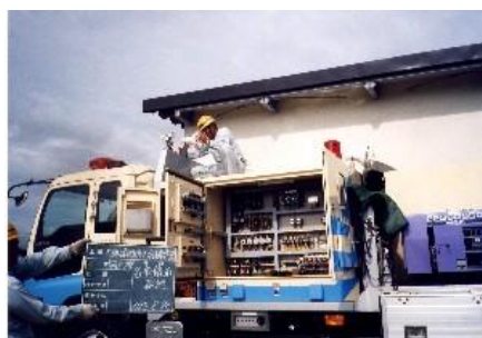
排水ポンプ車点検の様子
