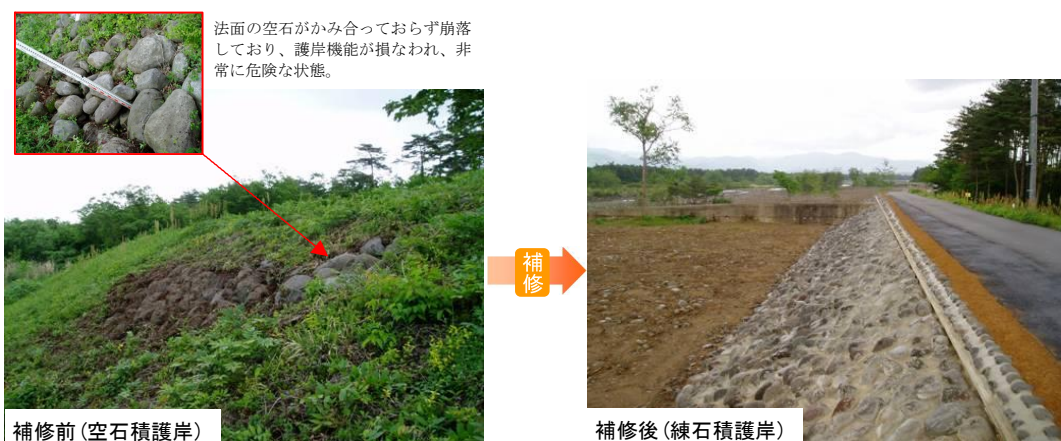
空石積護岸の補修(支川荒川)
