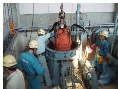
排水機場点検の様子
