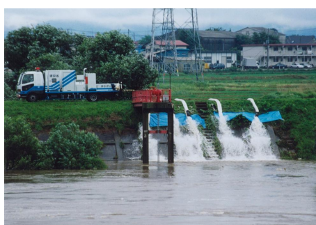
排水ポンプ車稼動状況(郡山市)
