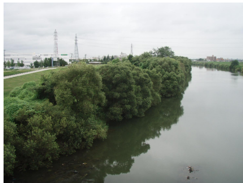
河岸に繁茂する樹木の状況
