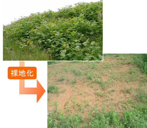
有害な植生の侵入による堤防の裸地
