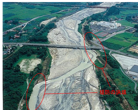
低水路の蛇行による堤防決壊 平成元年8月洪水 支川荒川
