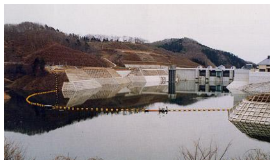
三春ダム 流木止施設
