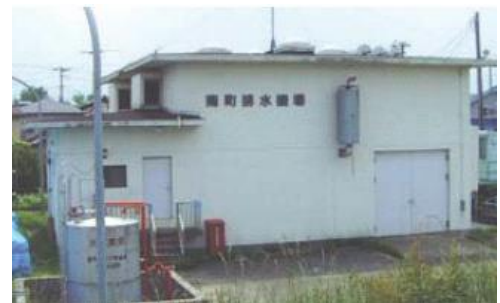
南町排水機場(福島市)
