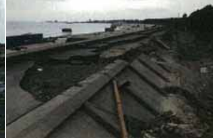
⑤七ヶ浜海岸 菖蒲田地区 (堤防天端裏法被災)
