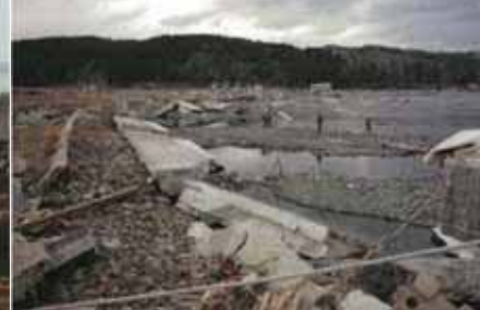
⑤七ヶ浜海岸 菖蒲田地区 (堤防天端裏法被災)
