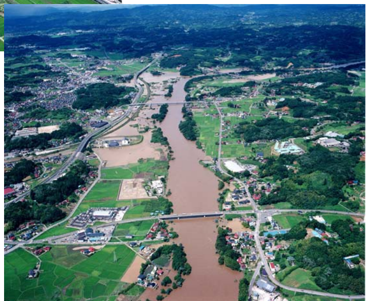
平成 14 年 7 月洪水 浸水状況（二本松・安達地区）
