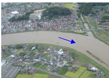
本宮地区築堤事業 (建設中)
