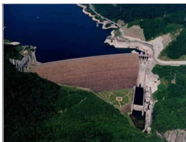
七ヶ宿ダム (H3 完成)
