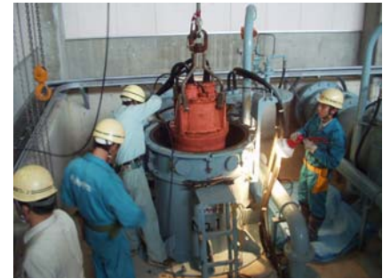
排水機場点検の様子
