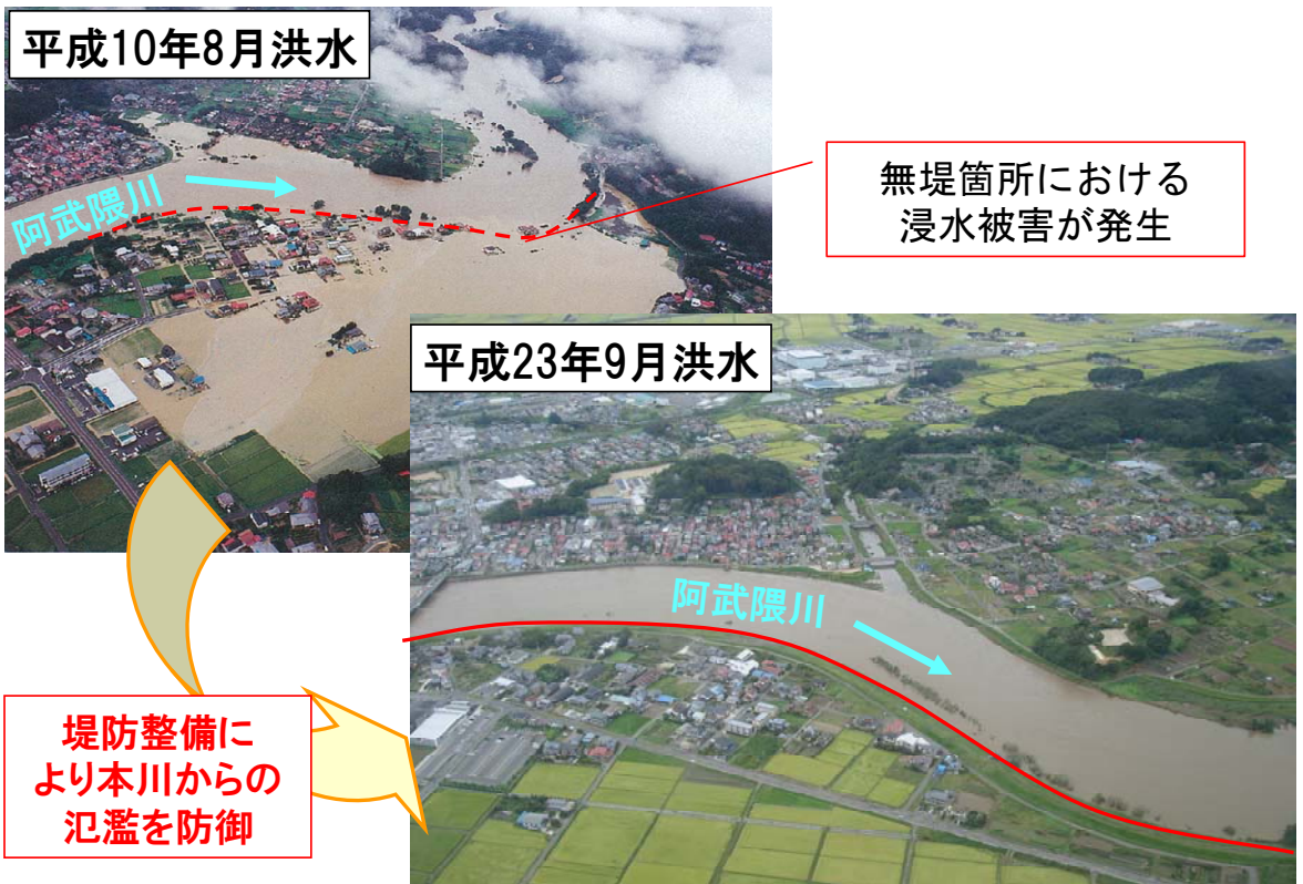
「平成の大改修」の効果（福島県本宮市）
