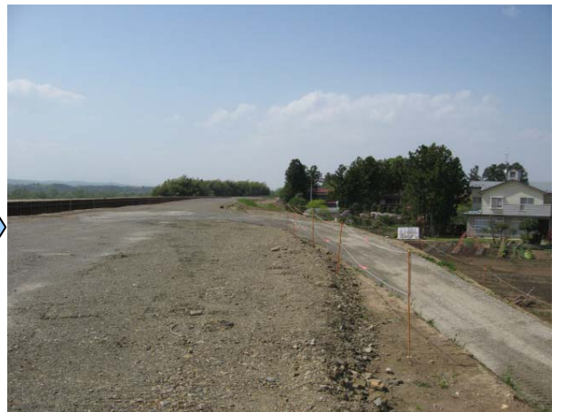
緊急復旧工事により被災前の堤防断面を確保
