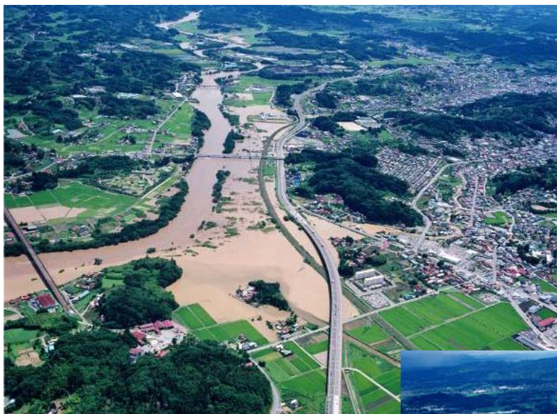
平成 14 年 7 月洪水 浸水状況（二本松・安達地区）
