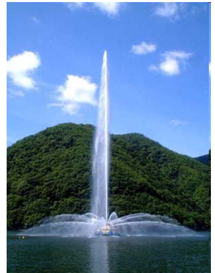
高さ 77m にまで及ぶ ダム湖の噴水施設
