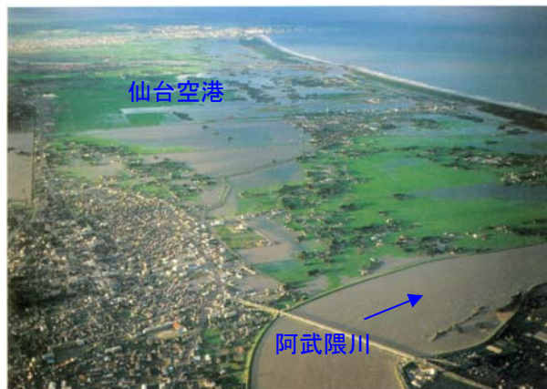
昭和 61 年 8 月洪水（岩沼市仙台空港付近）
