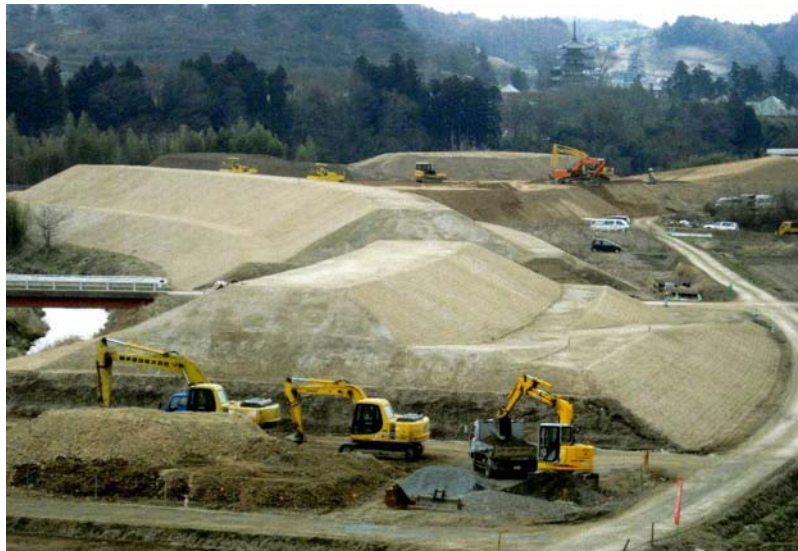
写真は「阿武隈川左岸油井地区築堤工事」の事例。(H18～H19)
