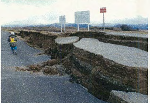
写真⑥ 護岸沈下状況 （県境から右岸11.0k付近 東根川地先）
