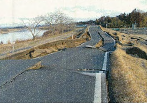
写真⑤ 堤防縦断亀裂 （河口から右岸33.0k付近 丸森町小斉地先）
