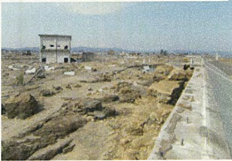
写真③ 堤防沈下 （河口から右岸22.0k付近 角田市坂津田地先）
