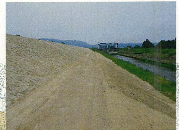
①東根川地区 堤防法面復旧状況
