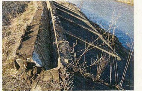
写真⑥ 護岸沈下状況 （県境から右岸11.0k付近 東根川地先）
