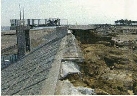
写真④ 堤防沈下 （河口から右岸31.0k付近 角田市枝野地先）
