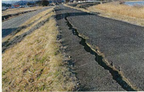
写真⑤ 堤防縦断亀裂 （河口から右岸33.0k付近 丸森町小斉地先）
