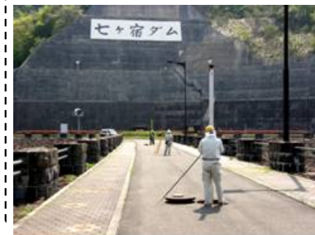
堤体変位測量
