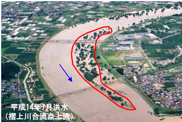
洪水時に流下阻害となる樹木群
