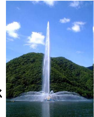
高さ77mにまで及ぶ ダム湖の噴水施設
