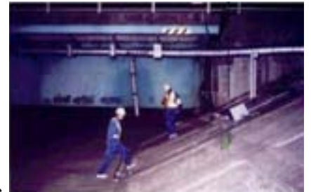
地震後の護岸点検状況 (国道6号阿武隈橋、平成15年5月26日)
