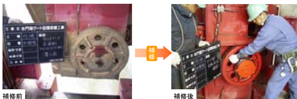
ゲート設備の維持補修
