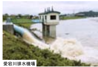
愛宕川排水機場
