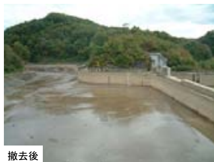
三春ダム前貯水池における堆積土砂の撤去
