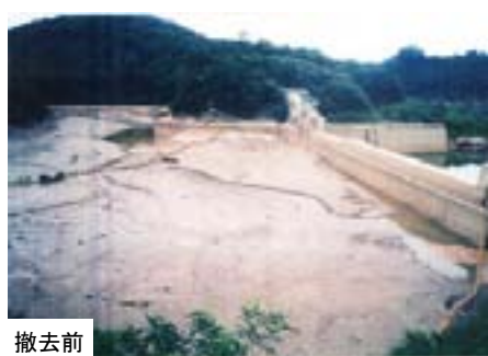
三春ダム前貯水池における堆積土砂の撤去
