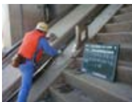
係船レールの点検状況
