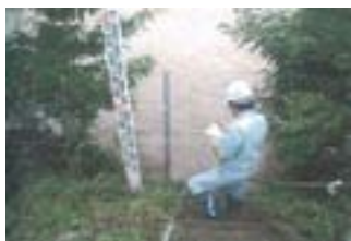
出水時の巡視の状況 (平成16年10月)
