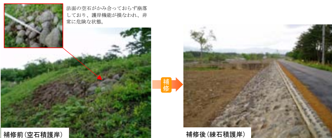
空石積護岸の補修(支川荒川)
