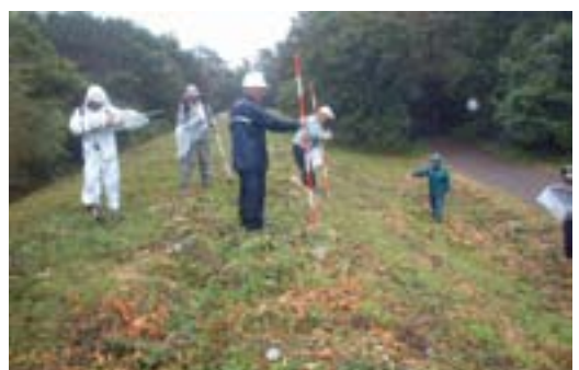
除草後の堤防モニタリング状況
