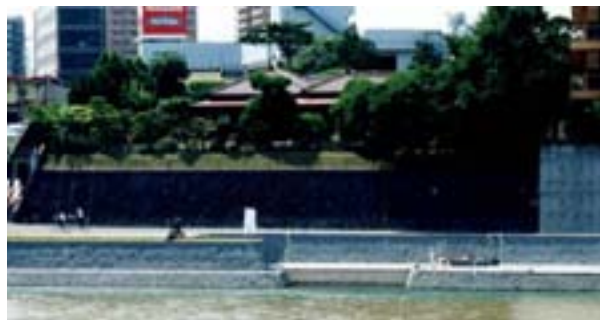
景観に配慮した護岸整備例（福島市御倉町） ～舟運の時代を偲んで復元された石積み護岸～
