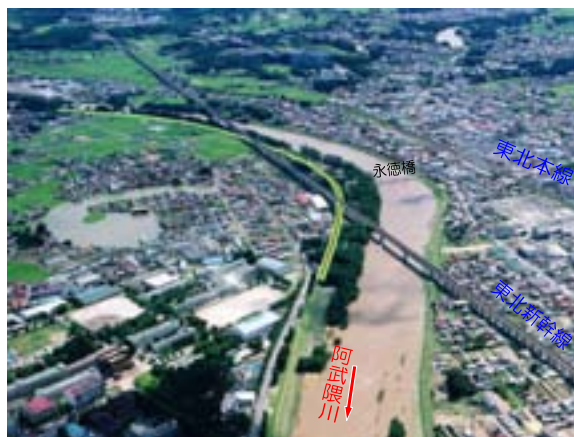
御代田地区(無堤箇所) 河口より140.6～142.4km右岸
