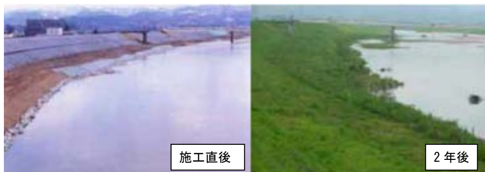
平成の大改修で行われた多自然川づくりの例(河口より60km付近)
