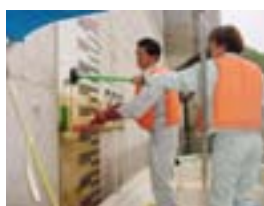
量水板の清掃状況
