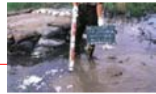
昭和61年洪水 漏水被害の状況
