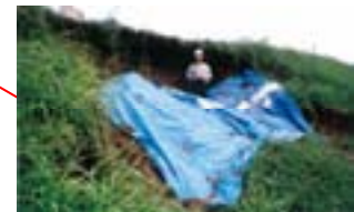
昭和61年洪水 法崩れ被害の状況
