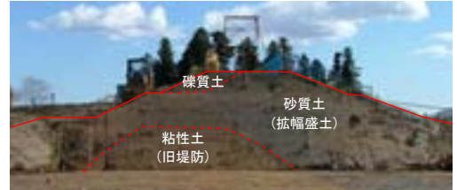
堤防開削断面 (阿武隈川下流 右岸36k付近)
