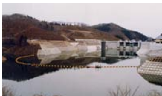
三春ダム 流木止施設
