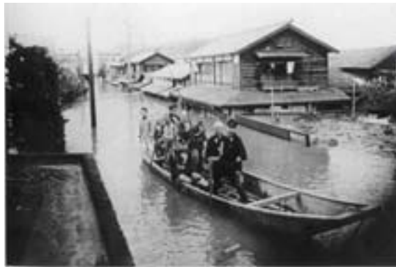
本宮町役場の冠水状況
