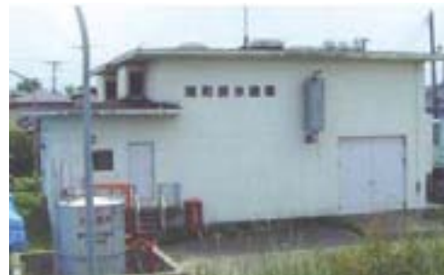
南町排水機場(福島市)
