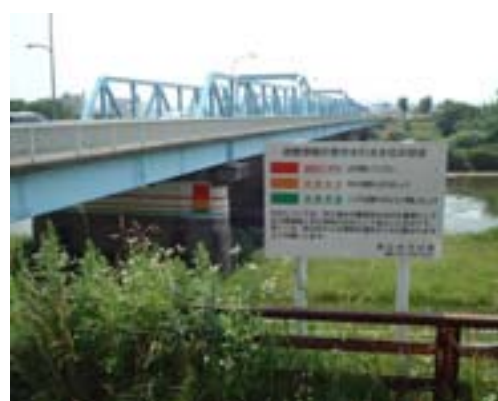
国道 49 号金山橋(郡山市)への避難情報の表示
