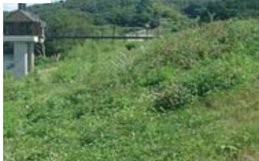
堤防除草により早期に発見された法崩れ
