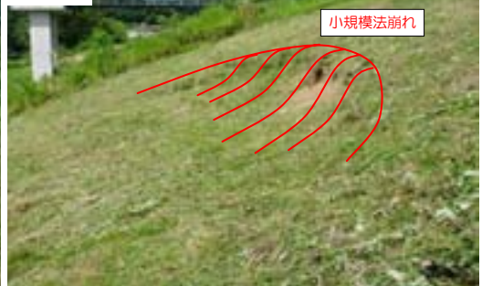
堤防除草により早期に発見された法崩れ
