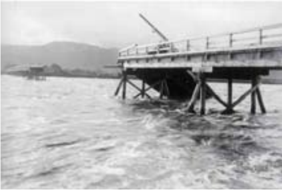
伊達崎橋の流失（福島県伊達市）
