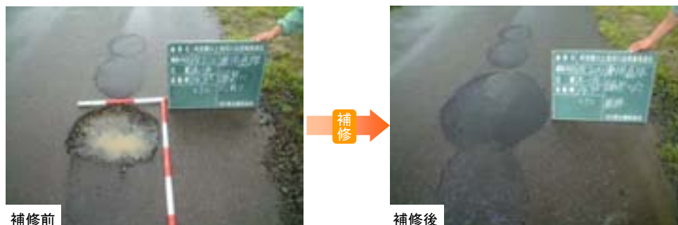
堤防天端舗装の補修
