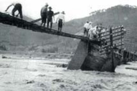
流失寸前の松川鉄道橋（福島県福島市）
