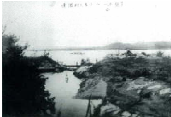
角田市平貫の堤防決壊
