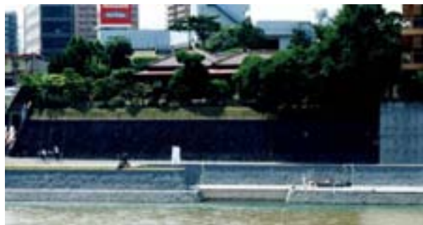
景観に配慮した護岸整備例（福島市御倉町） ～舟運の時代を偲んで復元された石積み護岸～
