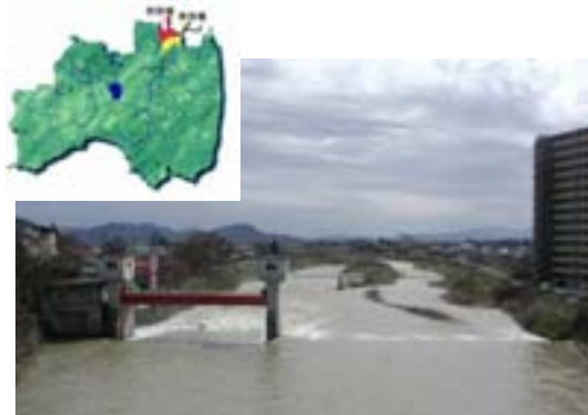
現在の伊達西根堰(福島市飯坂温泉付近)
