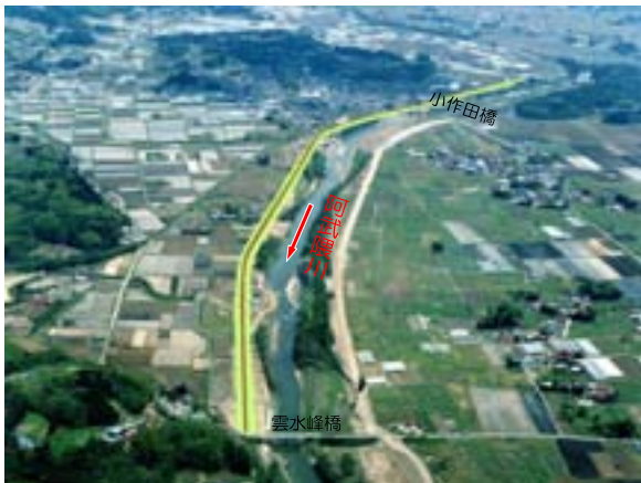
雲水峰地区(無堤箇所) 河口より151.4～154.0km右岸
