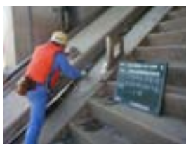
係船レールの点検状況
