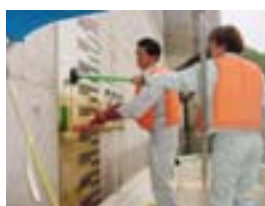
量水板の清掃状況
