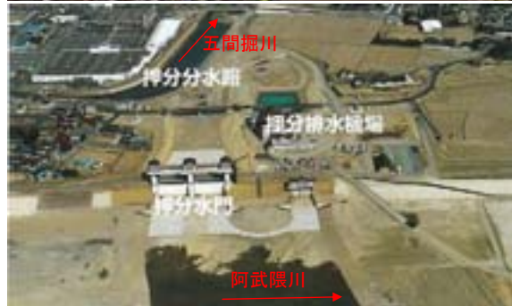
写真上：昭和 61 年 8 月 五間掘川付近浸水状況 写真下：分水路・水門・排水機場の整備 【出典：仙台河川国道事務所資料】
