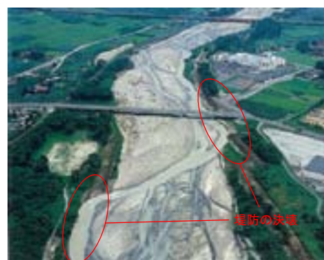
低水路の蛇行による堤防決壊 平成元年8月洪水 支川荒川
