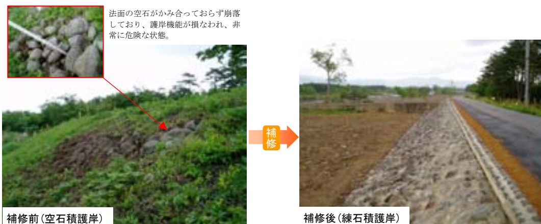
空石積護岸の補修(支川荒川)
