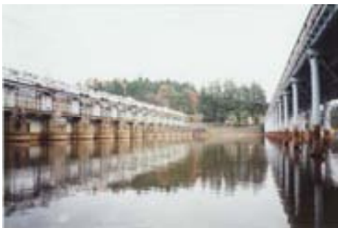
猪苗代湖水面水位調節施設 十六橋水門(明治13年)
