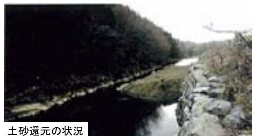
土砂還元状況
