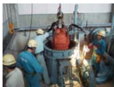
排水機場点検の様子
